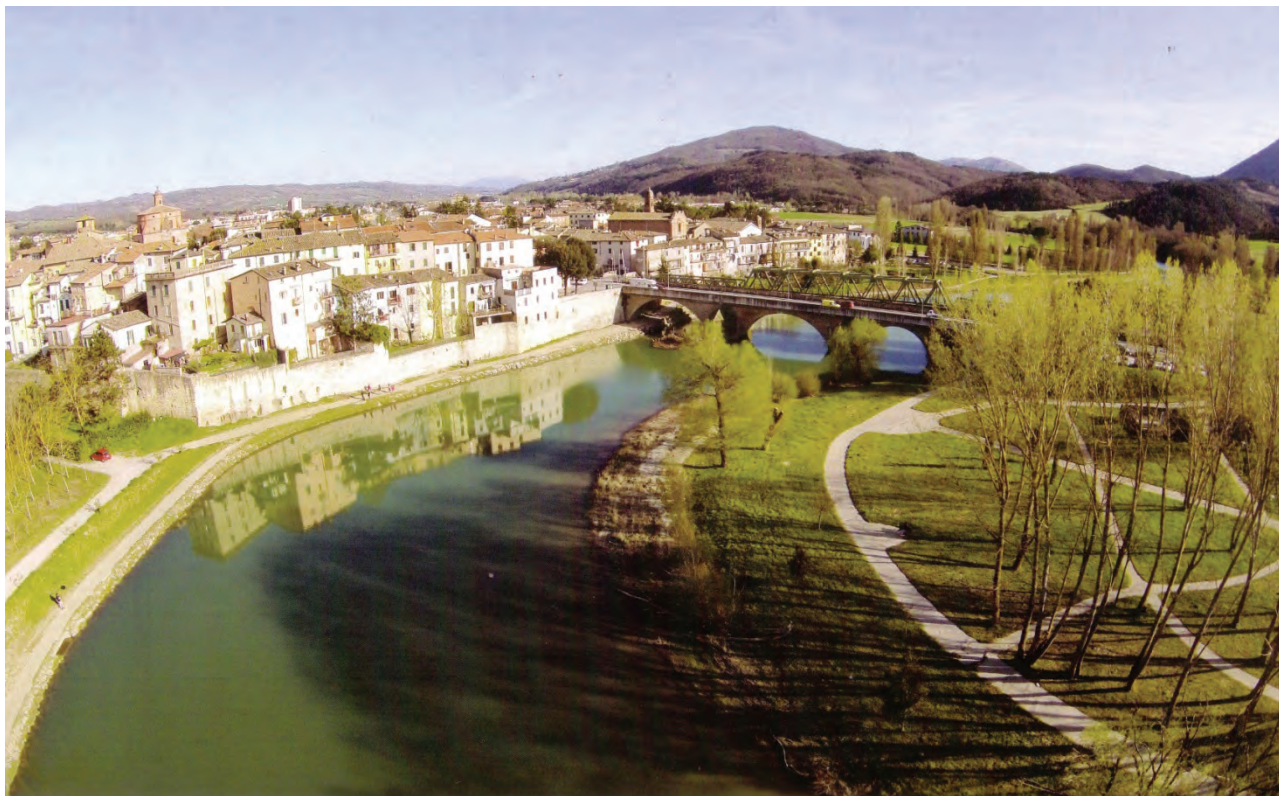
Centro storico e Parco Lido Tevere
