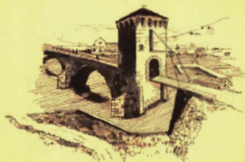
1390. Il ponte sul Tevere. La torre saracina con ponte levatoio all'estremo lato ovest. A destra la diga sul Tevere (vedi mese di agosto «Il Ponte»).
