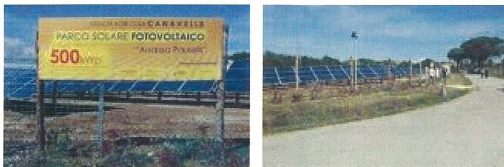
Figura n. 5 - Impianto di Canavelle nel comune di Umbertide
